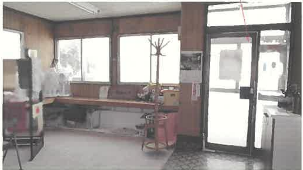
物件 2 建物内部の状況（1 階）
