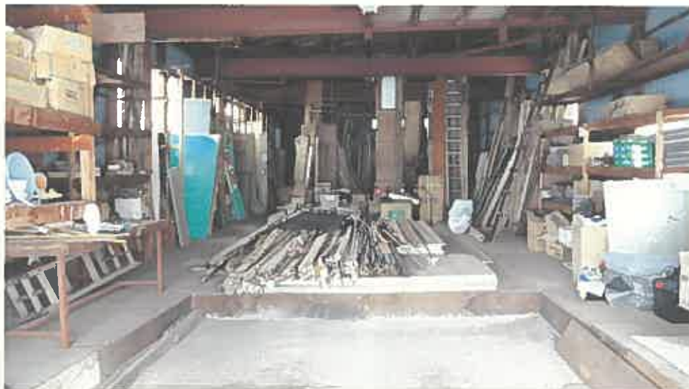
物件3主である建物内部の状況
