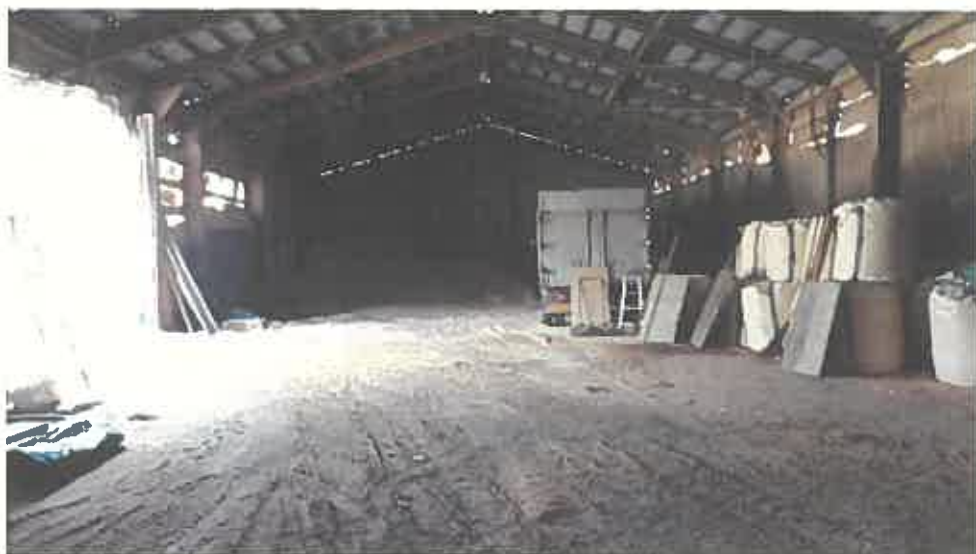
物件 5 主である建物内部の状況
