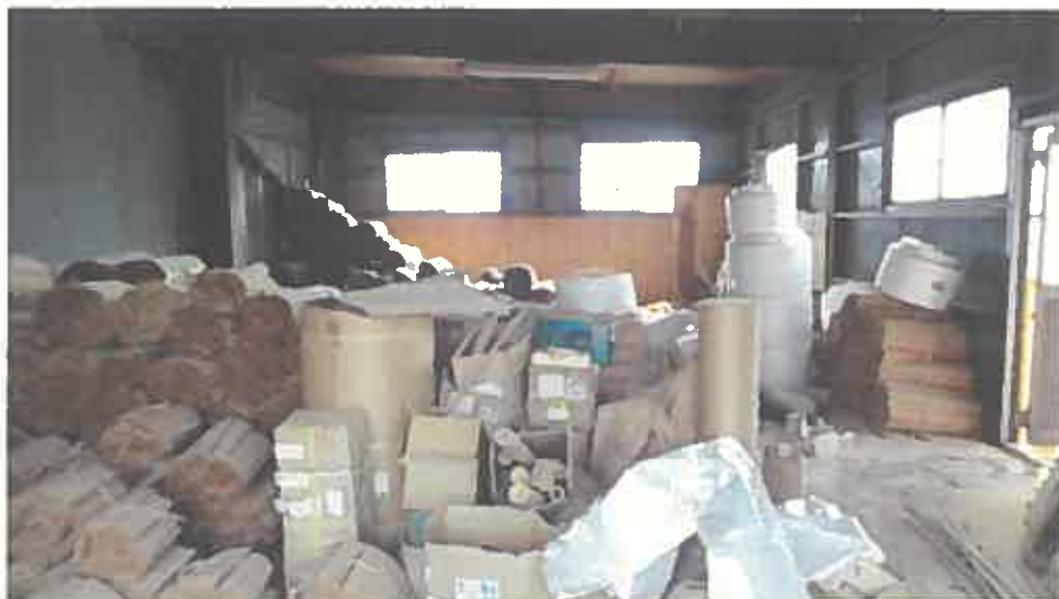
物件5 未登記附属建物内部の状況（2階）
