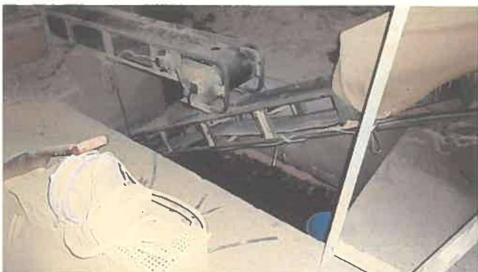
前同（床が一部掘り下げられている）
