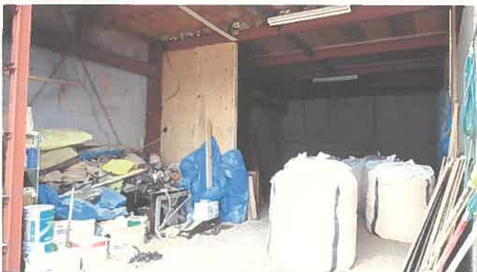
物件 5 未登記附属建物内部の状況（1 階）
