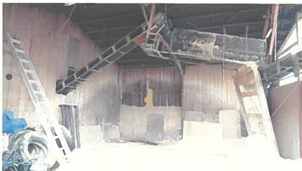
物件 4 建物内部の状況
