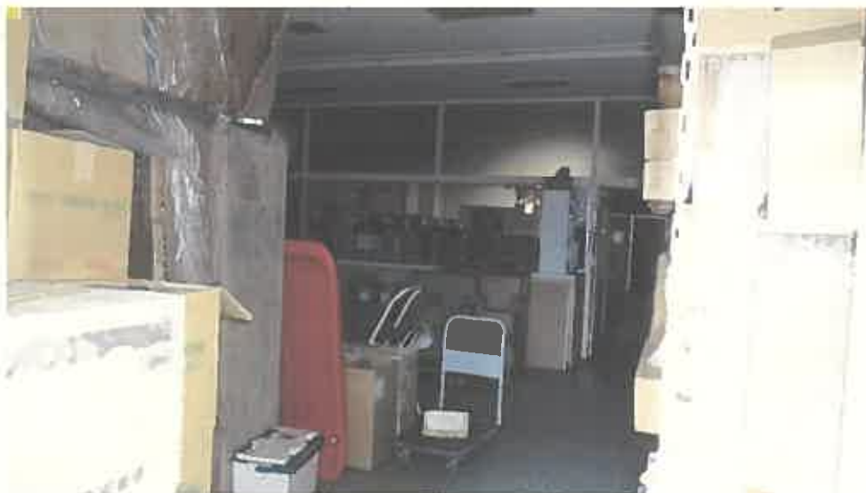
物件2建物内部の状況 (1階)
