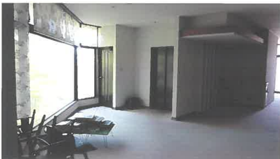
物件 6 建物内部の状況（3 階）
