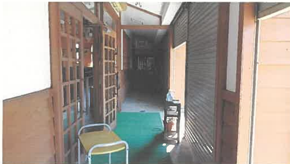
物件 3 主である建物内部の状況
