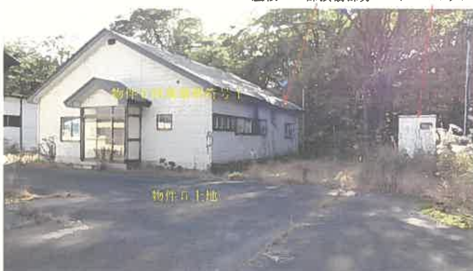
屋根の一部損傷部分 キュービクル
