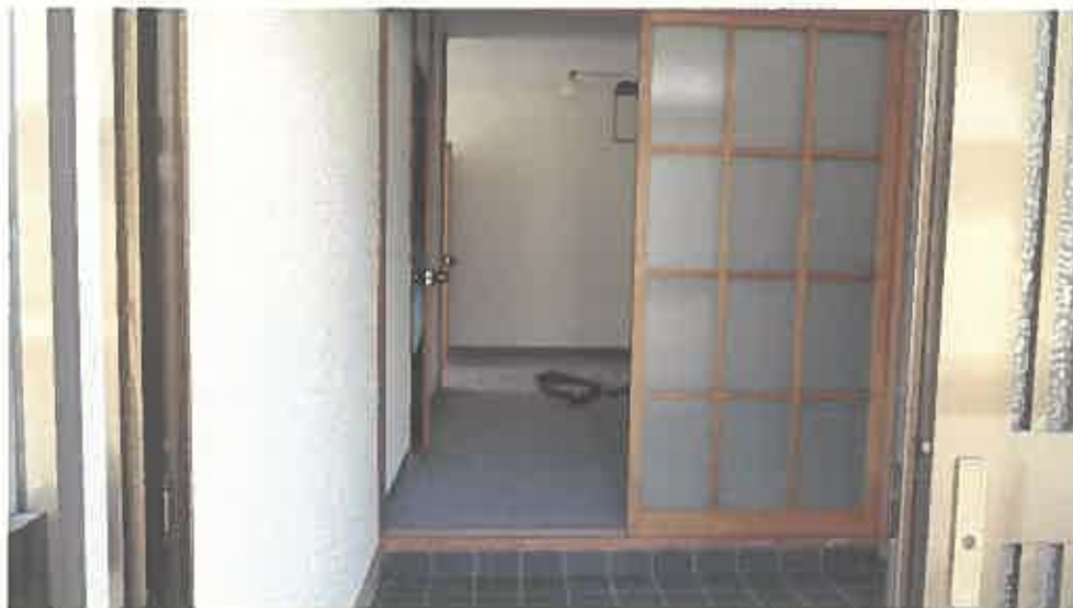
物件6 附属建物符号1 内部の状況
