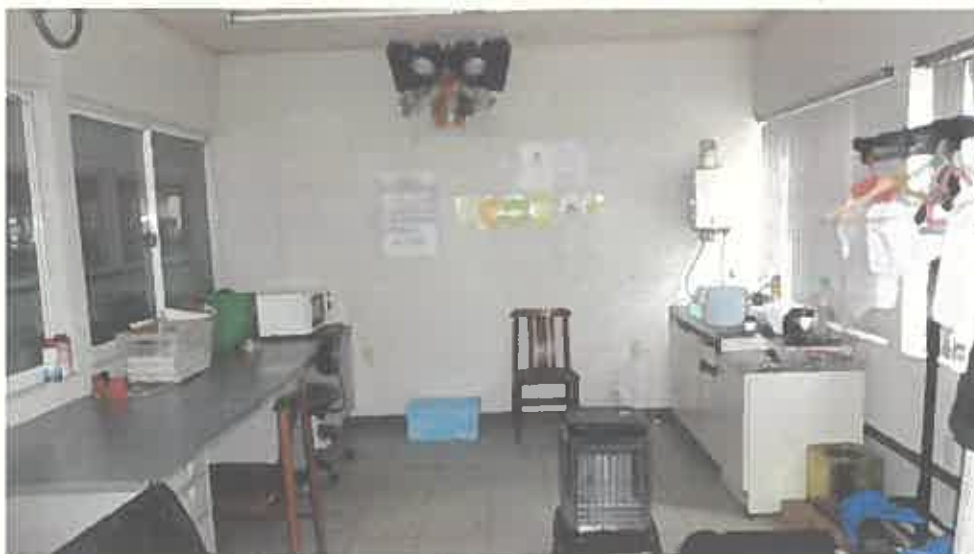
物件 6 主である建物内部の状況
