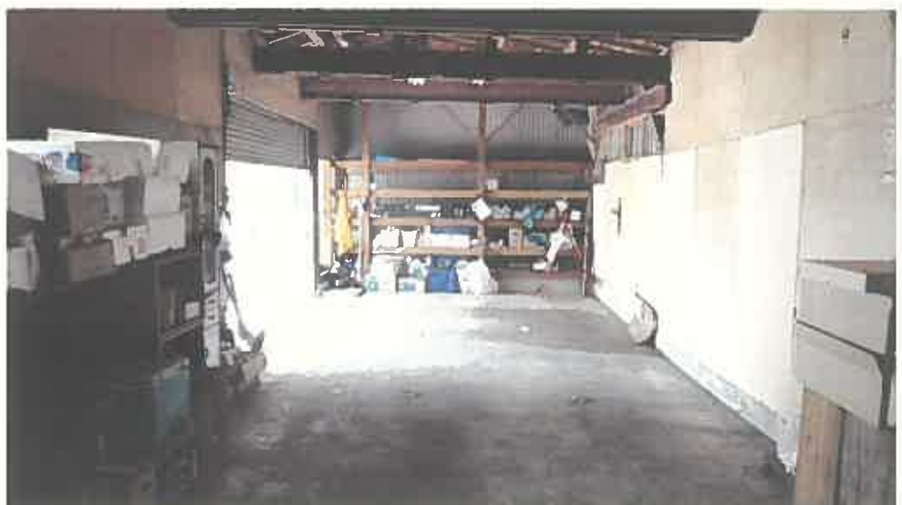
物件3未登記附属建物内部の状況
