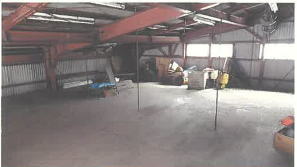
物件 4 主である建物内部の状況（2 階）
