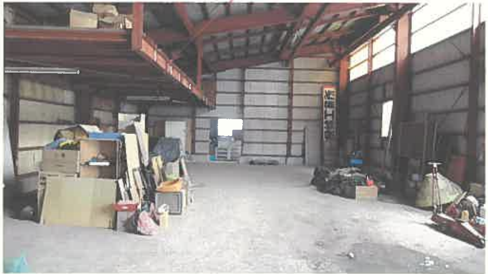
物件 4 附属建物符号 1 内部の状況
