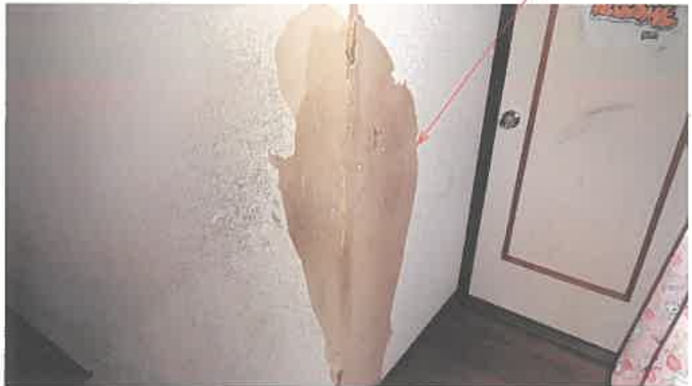
物件 2 主である建物内部の状況（2 階）
