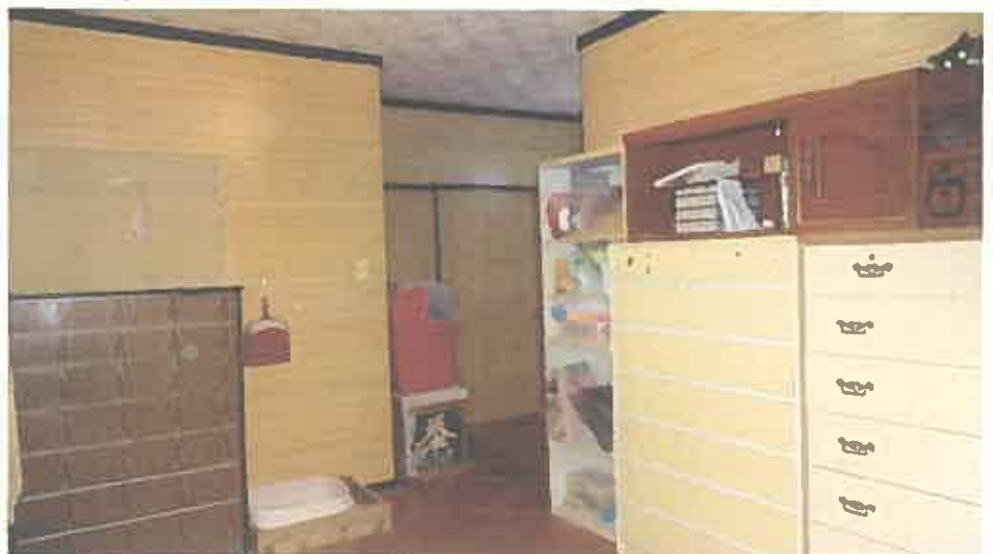
物件 2 主である建物内部の状況 (2 階)
