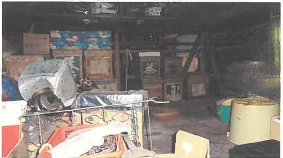
物件 2 附属建物符号 1 内部の状況 (2 階)
