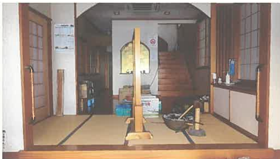
物件 3 建物内部の状況 (1 階)
