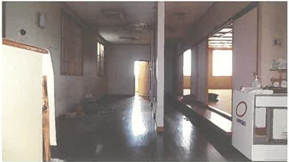
物件 3 建物内部の状況 (2 階)
