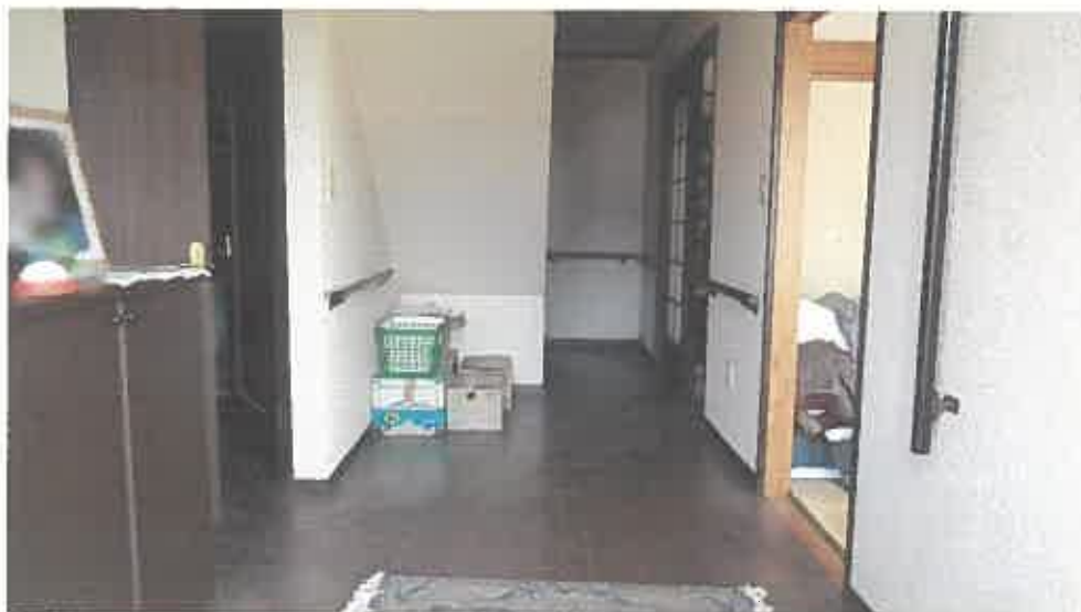
物件2建物内部の状況（1階）
