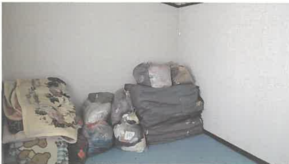
物件 2 建物内部の状況（2 階）
