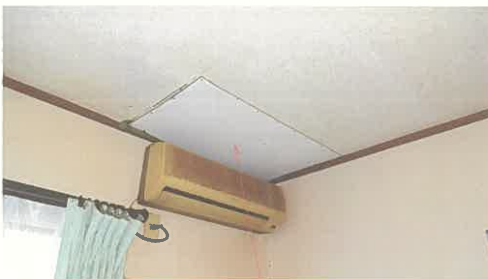
前同（天井の補修跡）
