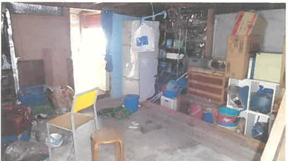
物件2 附属建物符号1 内部の状況（1 階）
