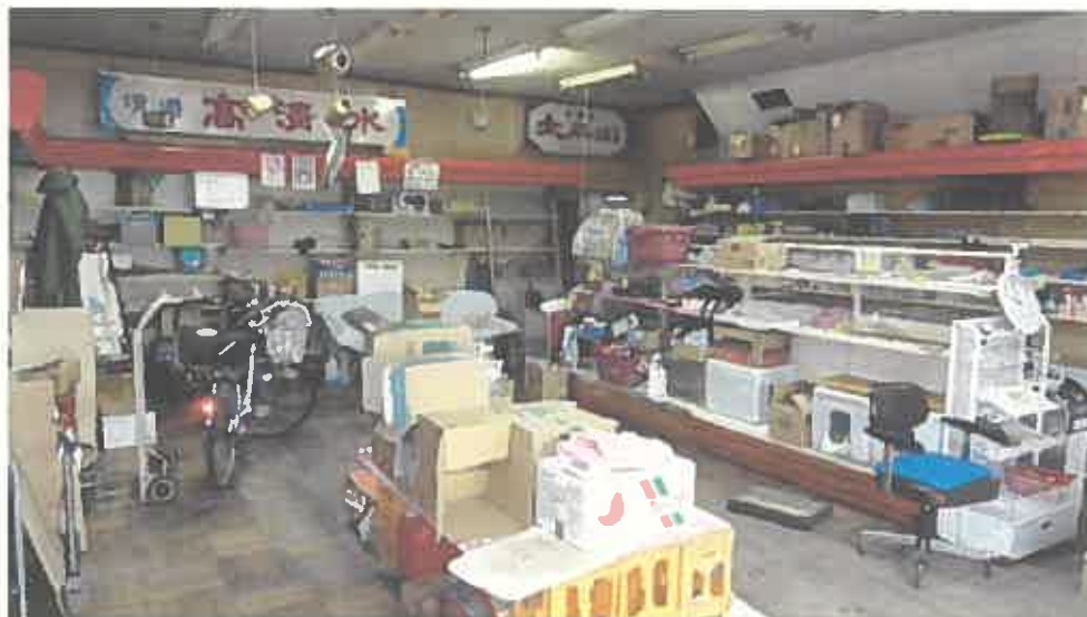
物件 2 主である建物内部の状況（1 階）
