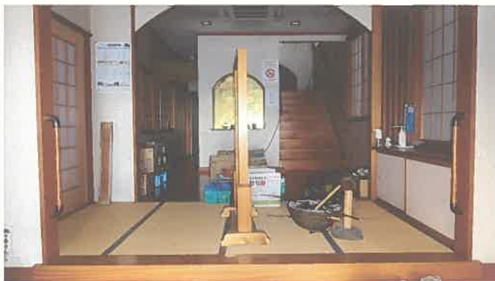
物件3建物内部の状況 (1階)
