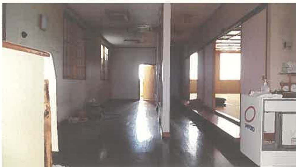
物件3建物内部の状況（2階）
