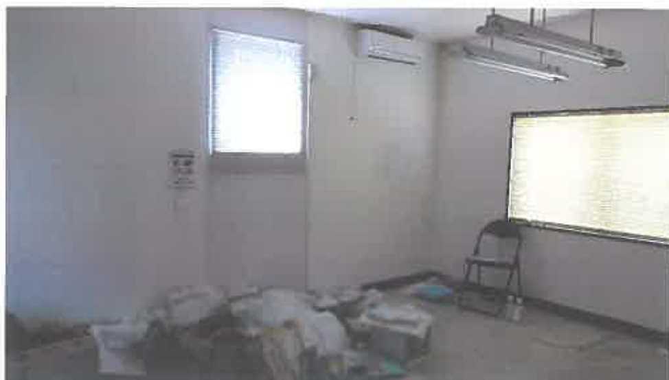
物件4建物内部の状況（2階）
