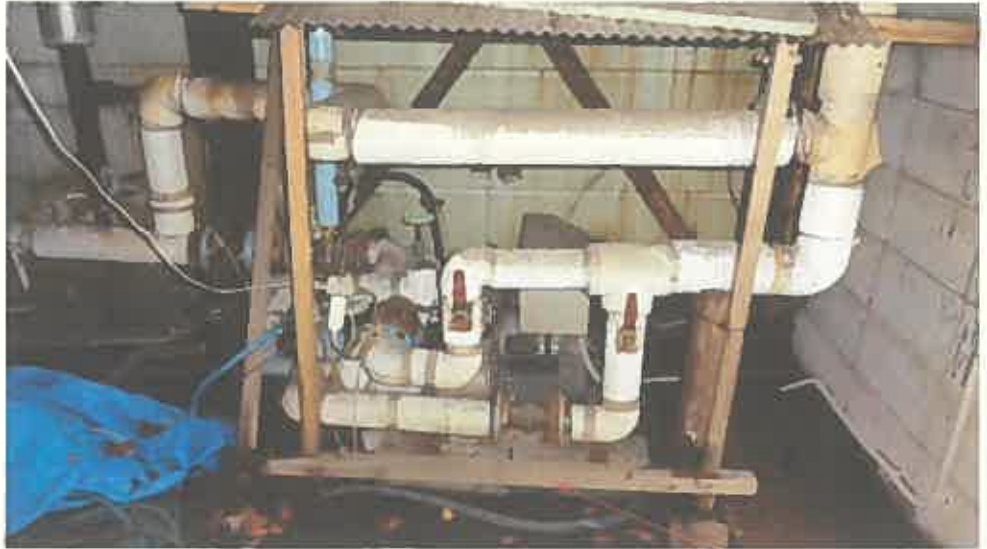
物件 1 6 未登記附属建物 1 内部の状況 (井戸)
