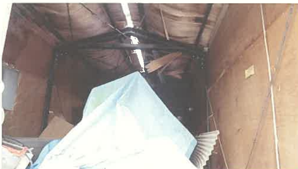
物件 1 2 未登記附属建物 1 内部の状況
