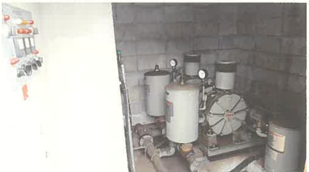
物件 1 6 未登記附属建物 2 内部の状況
