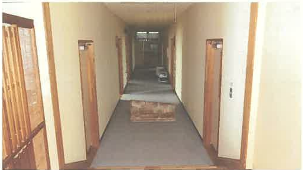
物件 15 建物内部の状況
