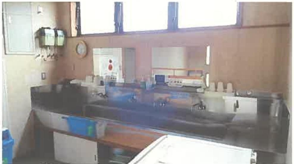
物件 1 2 主である建物内部の状況（2 階）
