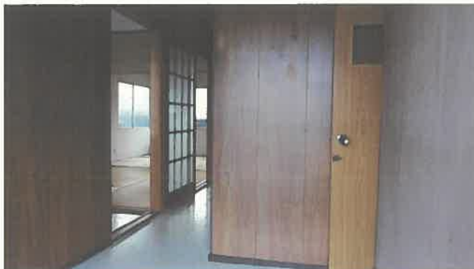
物件 6 建物内部の状況
