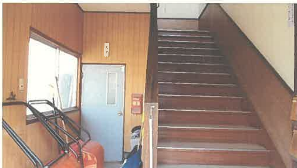
物件 5 建物内部の状況（1 階）
