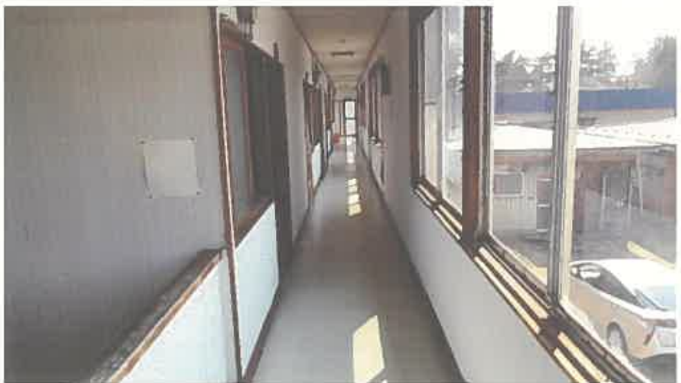
物件 2 建物内部の状況（2 階）
