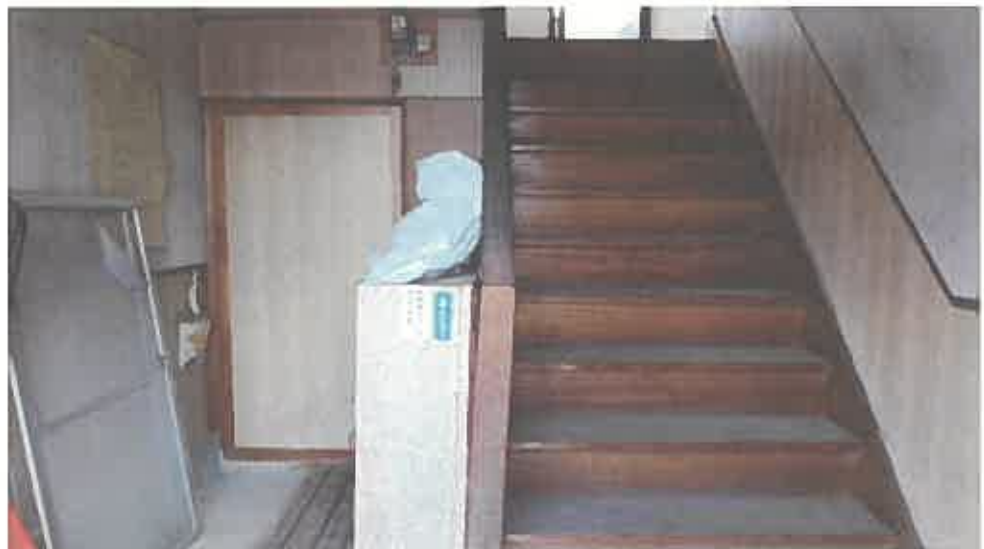
物件 9 建物内部の状況（1 階）
