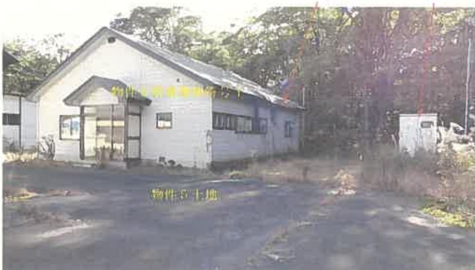
屋根の一部損傷部分 キュービクル
