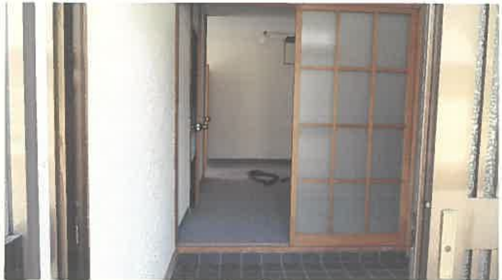
物件 6 附属建物符号 1 内部の状況
