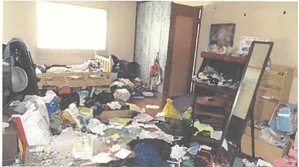
物件2建物内部の状況（2階）
