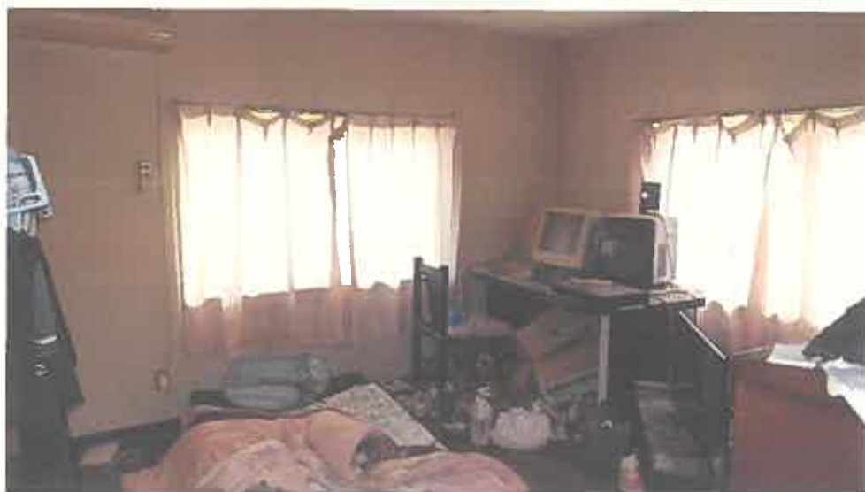
物件 2 建物内部の状況（2 階）
