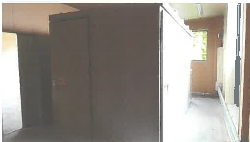
物件 6 建物内部の状況 (3 階)
