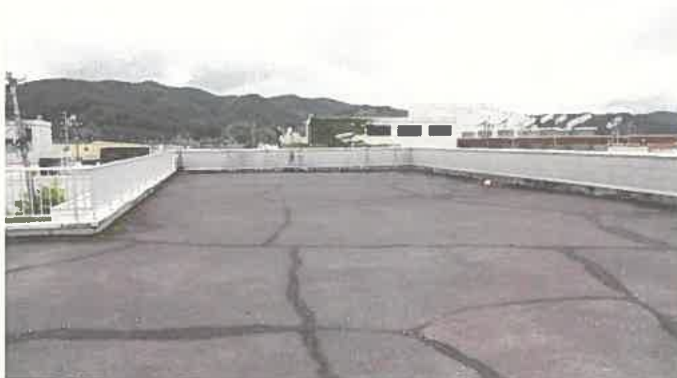
物件 6 建物 3 階屋上の状況
