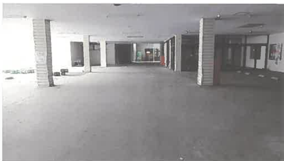
物件 6 建物内部の状況（1 階）
