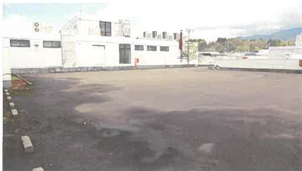
物件 6 建物 2 階屋上（駐車場）の状況
