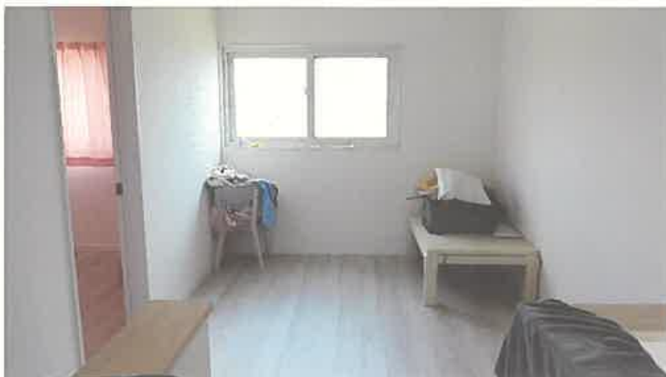
物件 2 建物内部の状況（2 階）
