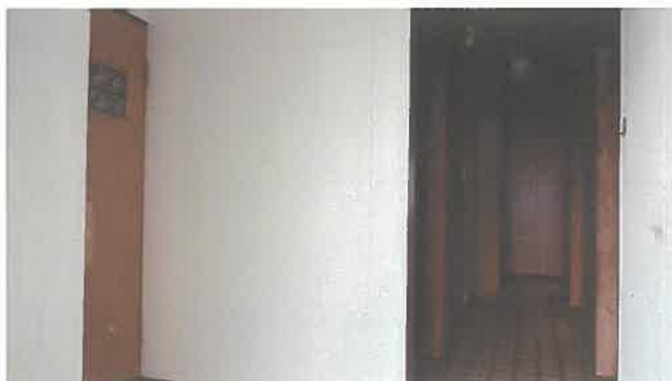
物件 7 建物内部の状況
