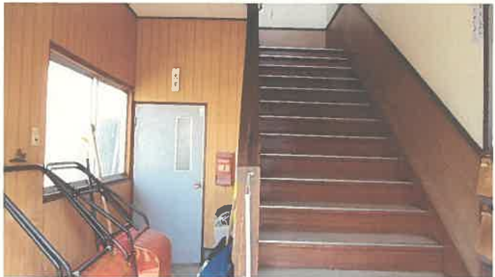
物件 5 建物内部の状況（1 階）
