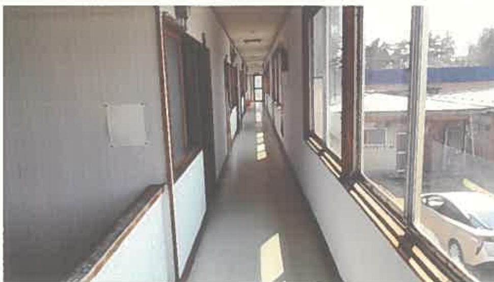
物件 2 建物内部の状況（2 階）
