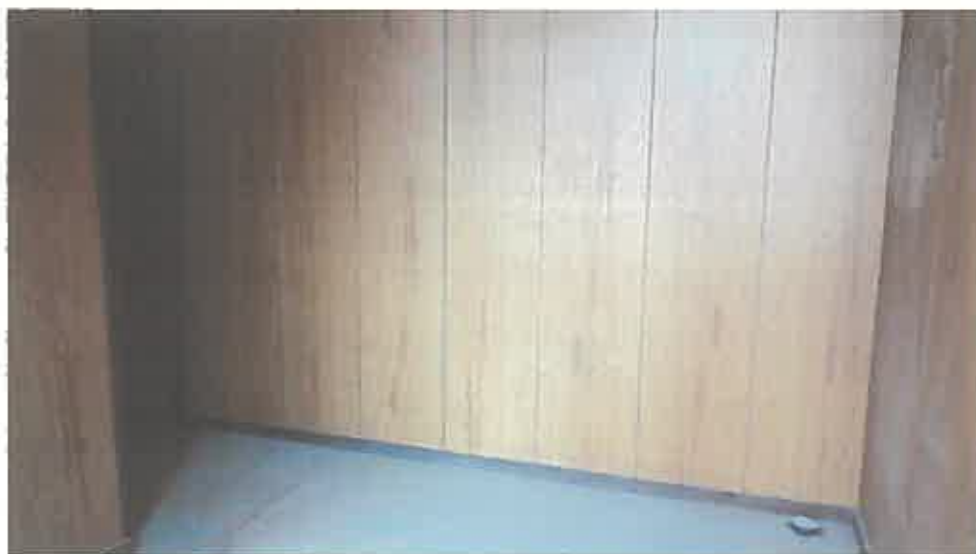
物件 8 建物内部の状況
