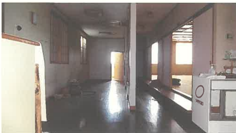
物件 3 建物内部の状況（2 階）
