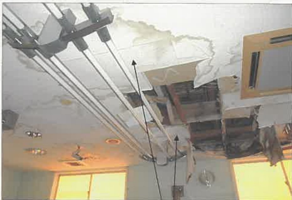
天井の破損、雨漏りの跡
