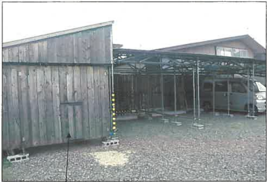
賃借人が設置した構築物
