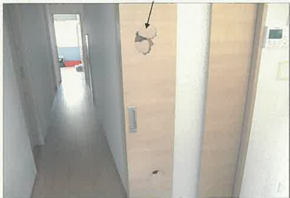
ドアの損傷
