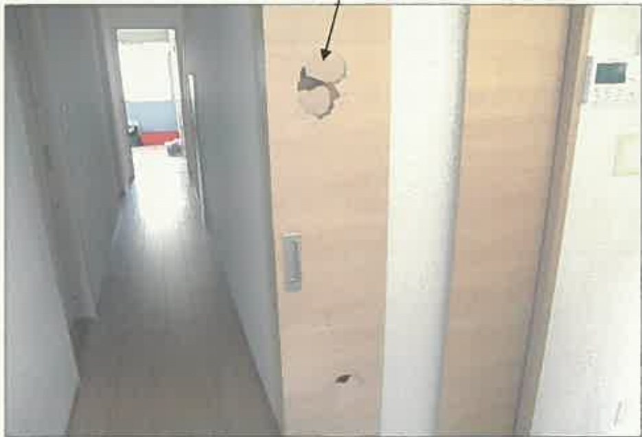
ドアの損傷
