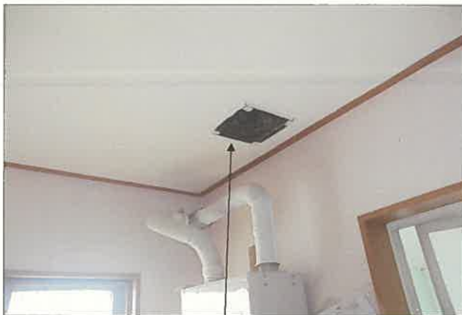
換気扇のカバーが取れている
