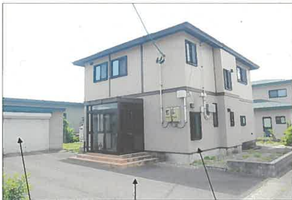
附属建物符号1(車庫)
