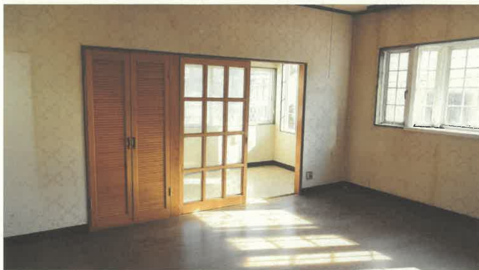
物件 2 建物内部の状況（2 階）
