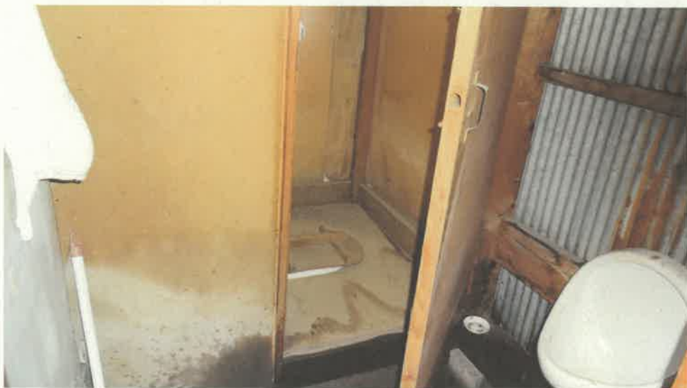
物件 2 建物内部の状況（トイレ）
