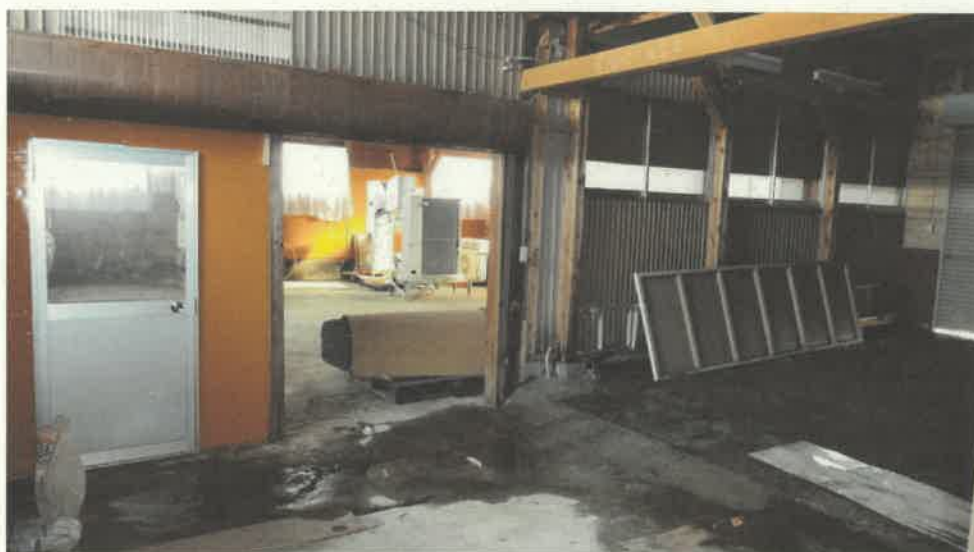
下屋内部（東側隣接建物との接続状況）
