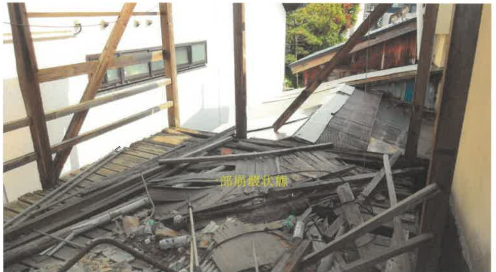
物件 2 建物内部の状況（2 階）
