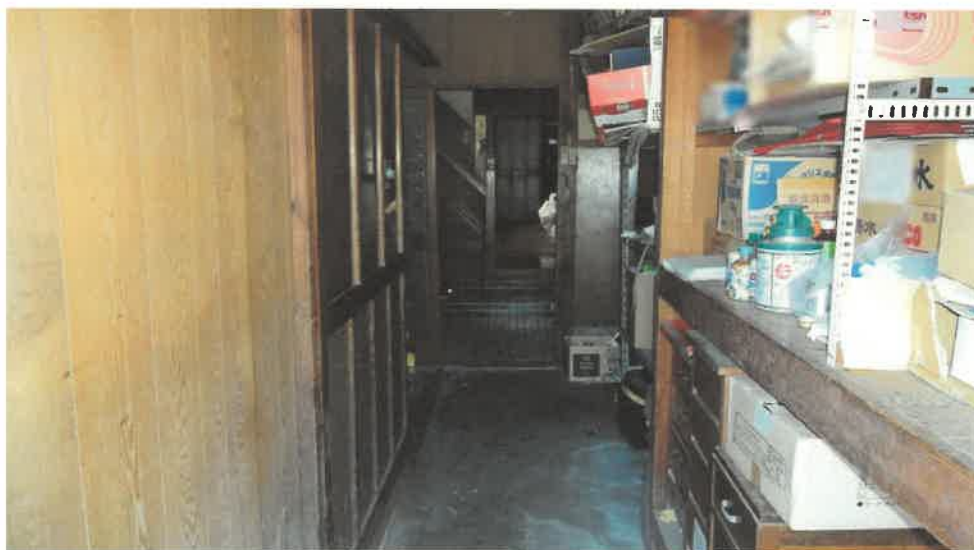
物件 3 建物内部の状況 (1 階)
