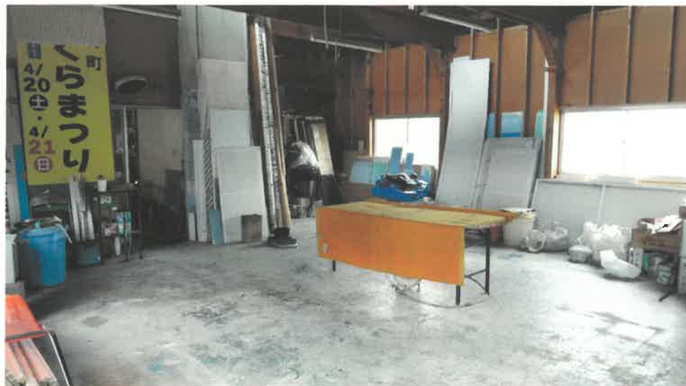
物件 4 建物内部の状況
