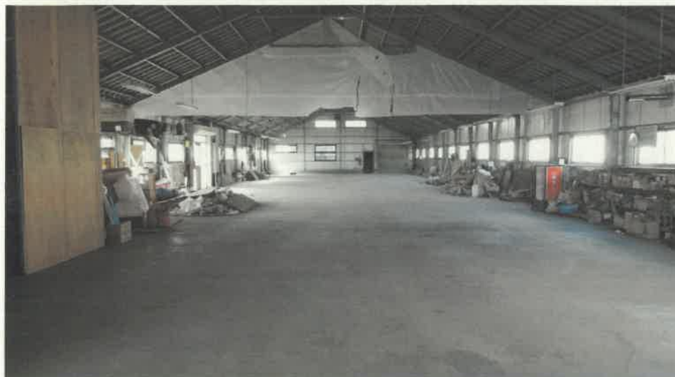
物件 8 主である建物内部の状況
