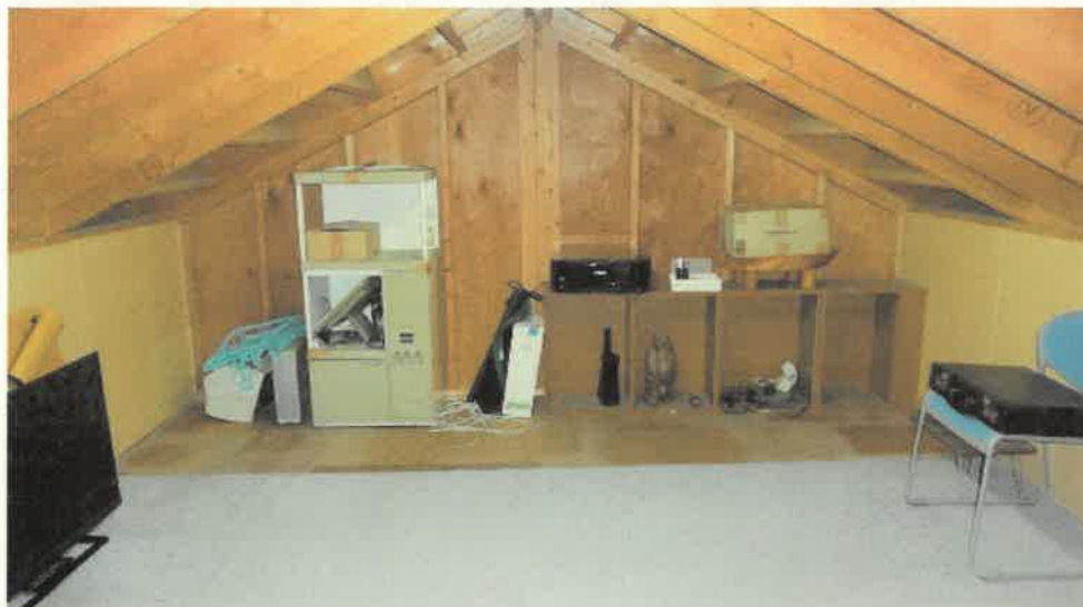
物件 2 主である建物内部の状況（2 階）
