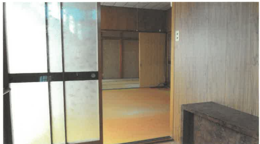
物件7主である建物内部の状況
