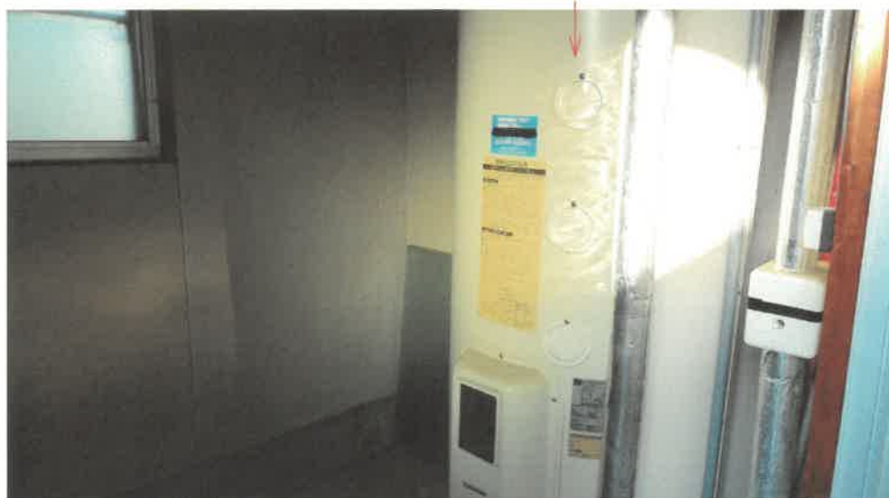
物件 7 未登記附属建物内部の状況
