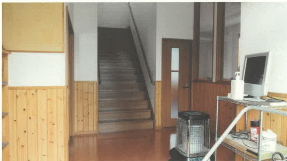
物件 2 建物内部の状況 (1 階)
