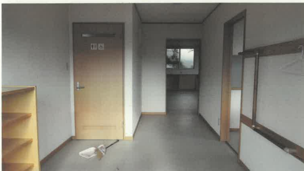
物件 3 建物内部の状況
