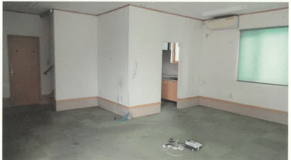
物件 4 建物内部の状況 (1階)
