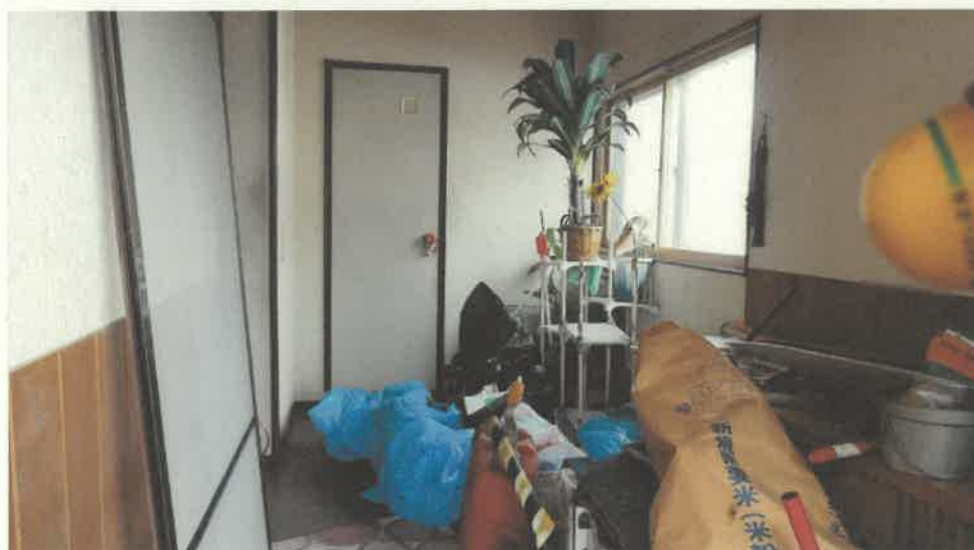
物件 2 建物内部の状況
