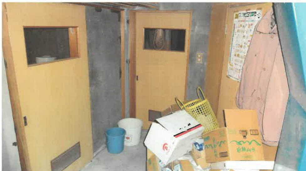
物件 3 建物内部の状況（地下）
