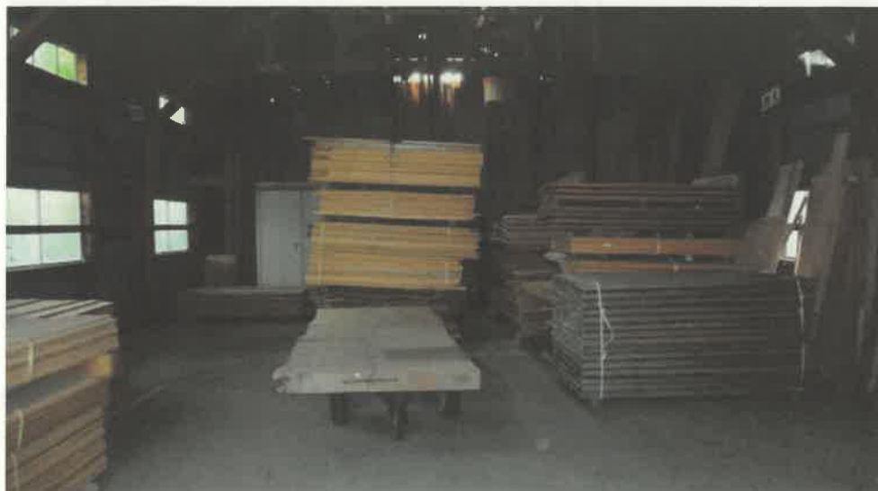
物件 1 2 附属建物符号 6 内部の状況
