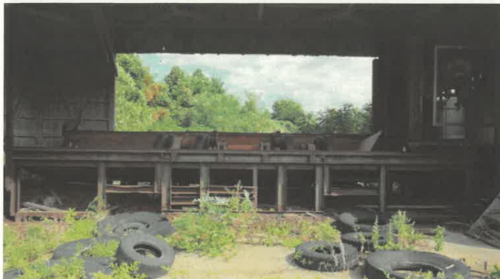
物件 1 2 附属建物符号 4 内部の状況
