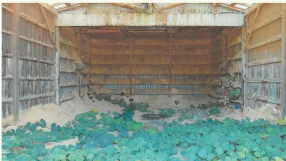
物件 2 附属建物符号 1 内部の状況（1 階）
