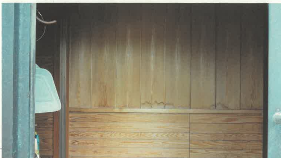
物件 1 2 附属建物符号 1 内部の状況（1 階）
