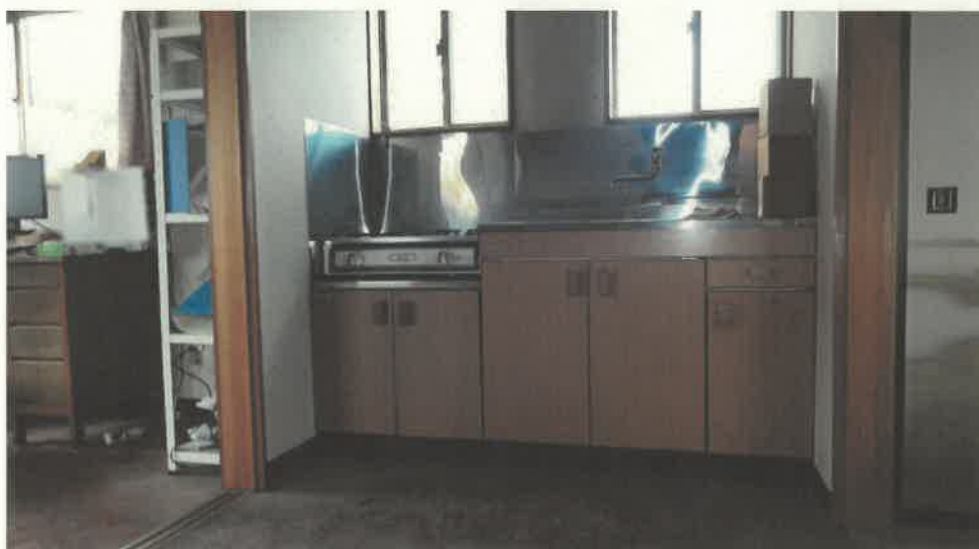
物件 1 2 附属建物符号 1 内部の状況（2 階）
