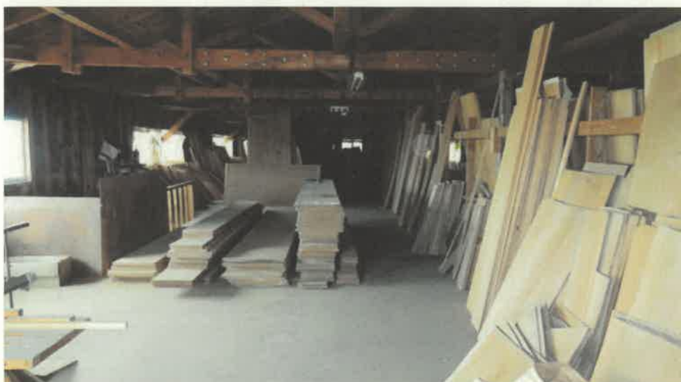
物件 1 2 附属建物符号 7 内部の状況 (2 階)
