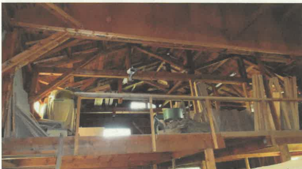
物件 1 2 附属建物符号 5 内部の状況 (2 階)
