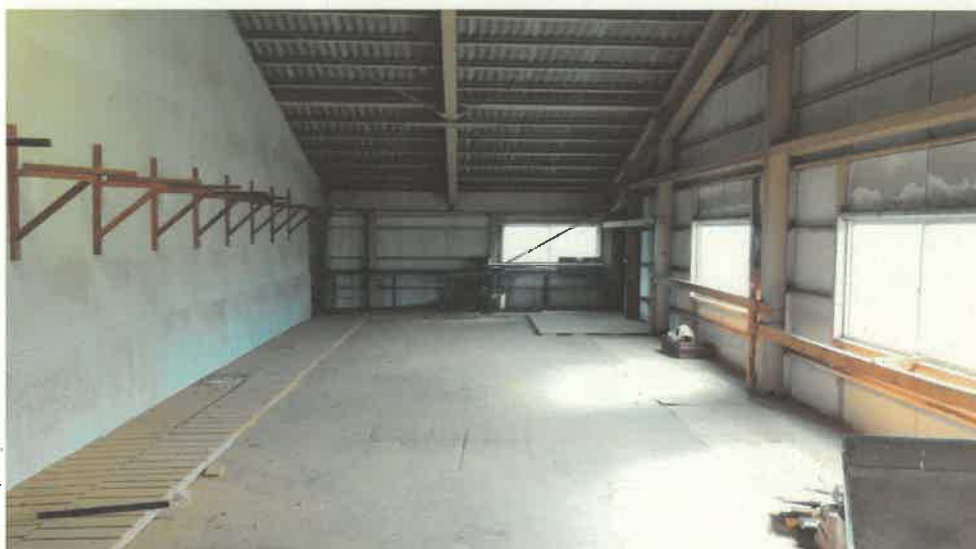
物件 1 2 主である建物内部の状況（2 階）
