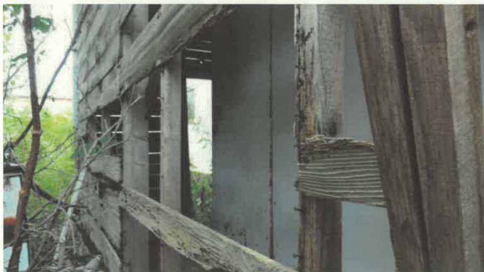
物件 1 2 附属建物符号 3 内部の状況
