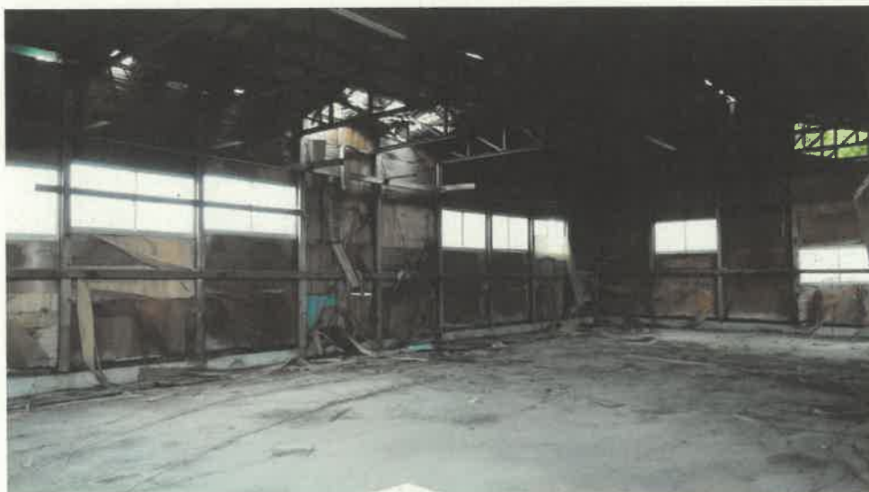
物件 9 附属建物符号 2 内部の状況
