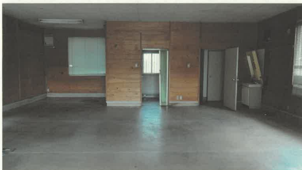
物件 9 主である建物内部の状況
