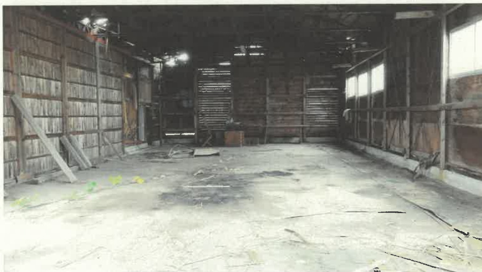
物件 9 附属建物符号 1 内部の状況
