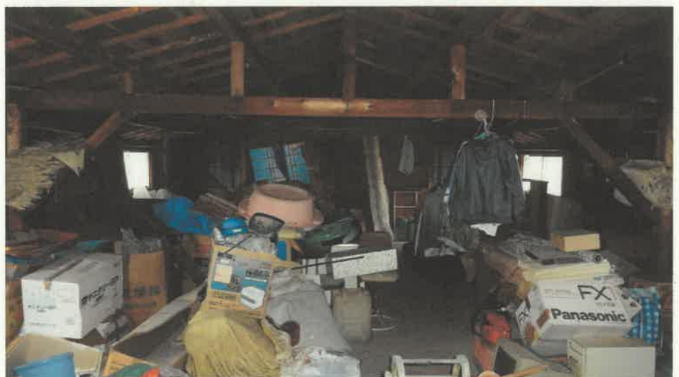
物件 2 未登記附属建物内部の状況（2 階）
