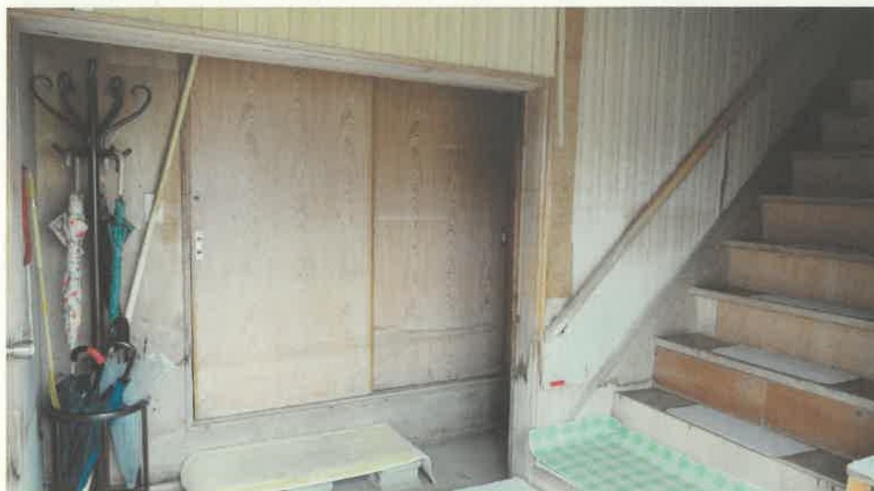
物件 2 4 建物内部の状況（1 階）
