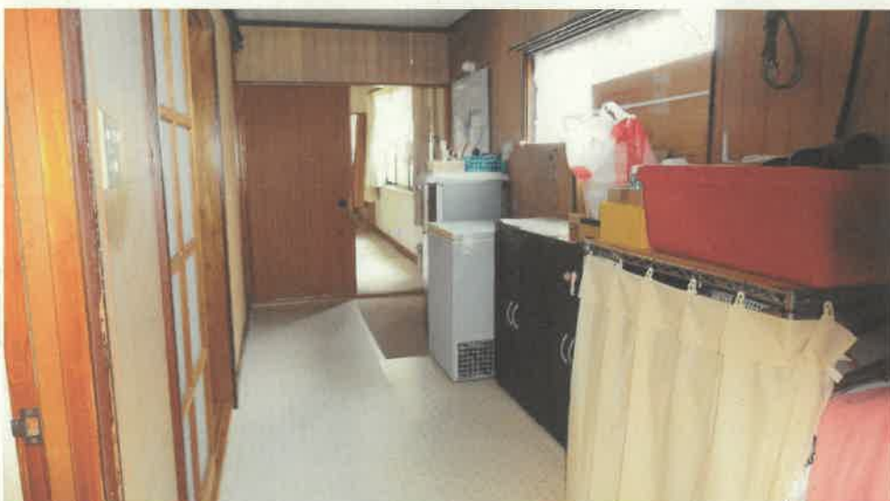
物件 24 建物内部の状況 (2 階)
