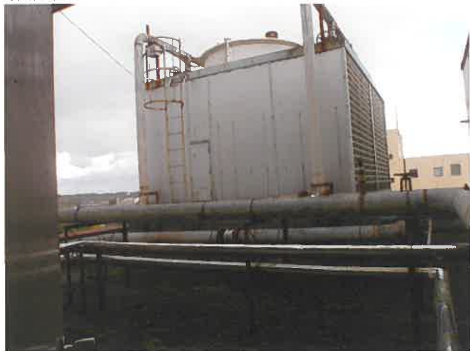
物件 2 屋上の水槽
