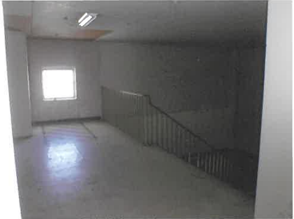
物件2 4階階段（北側）
