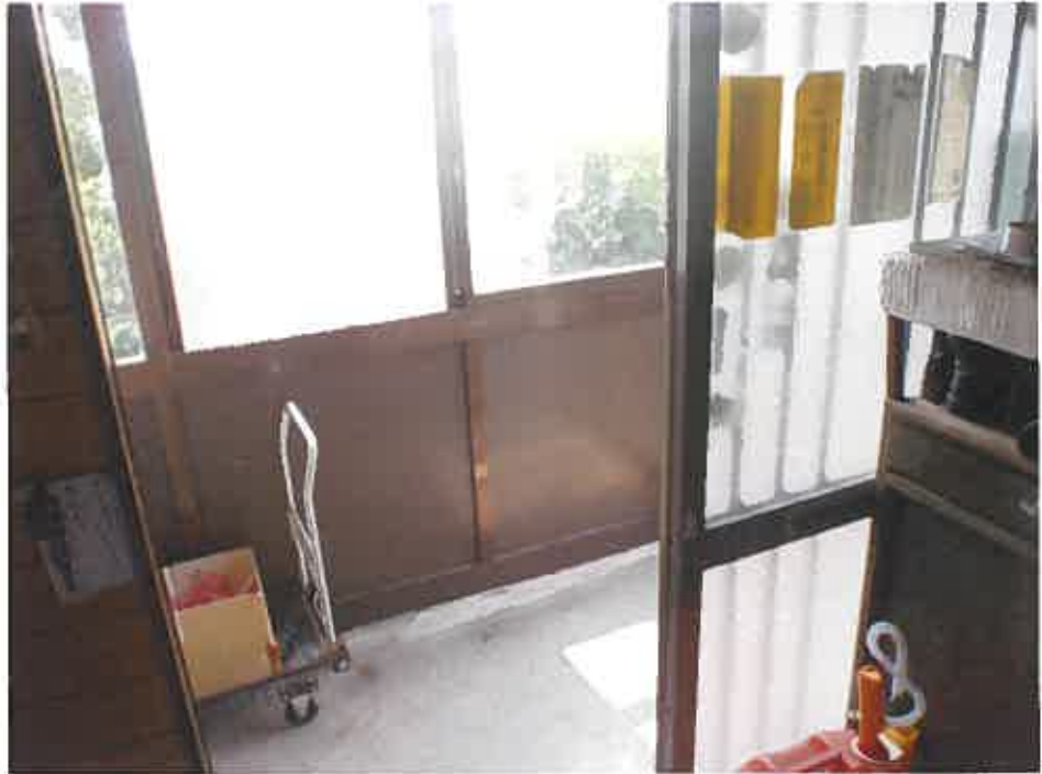
物件 6 玄関と風除室（西側）
