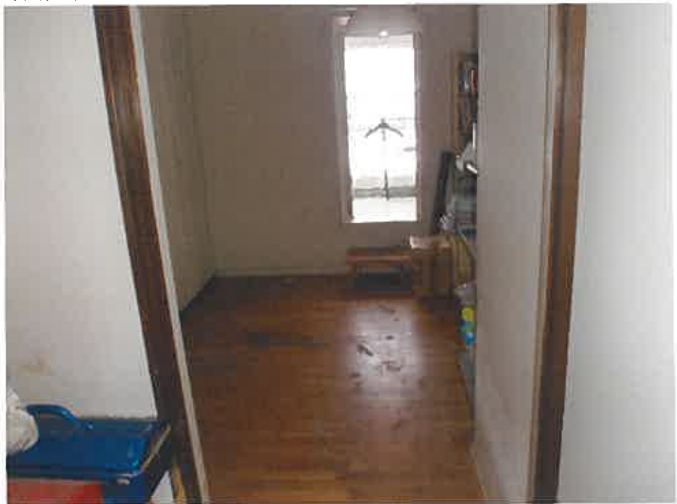
物件 2 2階廊下から洋室（北側）方向
