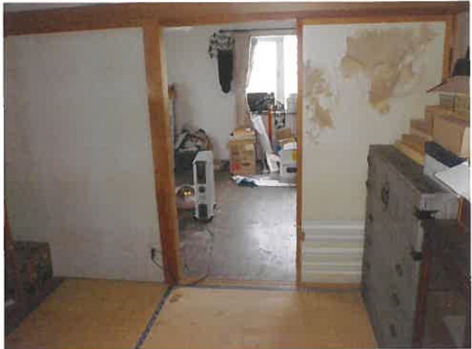
物件 2 2階和室から洋室（南側）方向
